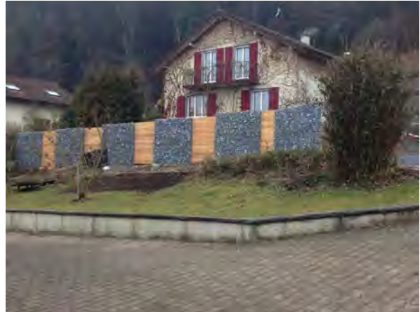
Gabione auf privater Fläche Quelle: SL-FP 2016
