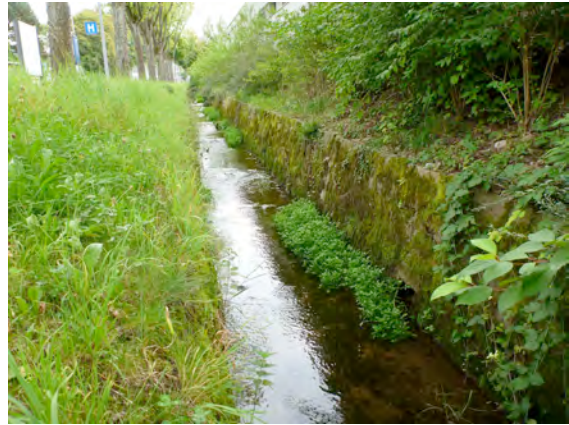
D: Südstr. Kanalisiert, Sohle verbaut
