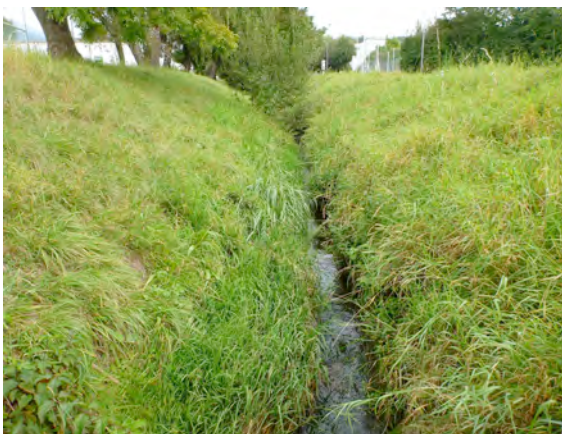
E: Sportanlage Lengg; kanalisiert
