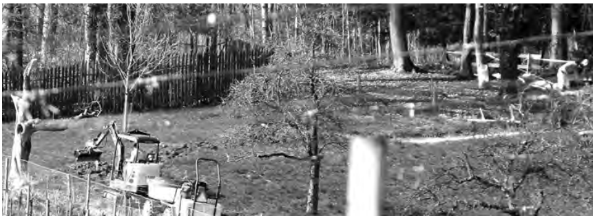
Bau der neuen Wegverbindung durch den Burghölzliwald im März 2015. Foto: Christine Dobler Gross
