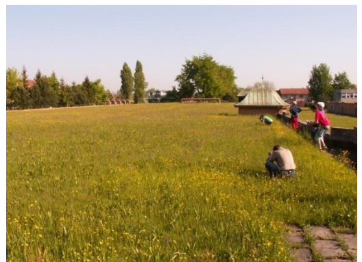
humusiertes Flachdach Wollishofen
